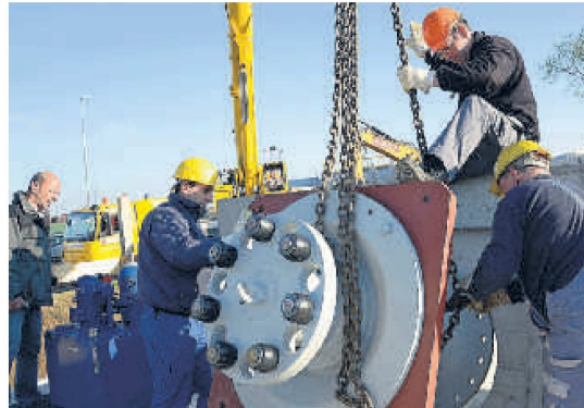
Das Montageteams von Arnold Systems Olten beim Einbauen des oberen Lagers.
