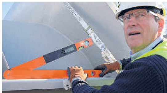
Firmeninhaber Louis Arnold dirigierte den Einbau der Schnecke persönlich, die genau 23 Grad schräg am Kran hängen muss.
